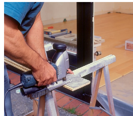
13 Skrajne panele w rzędach przycinamy wyrzynarką od strony spodniej lub ręczną piłą tarczową od strony wierzchniej.
