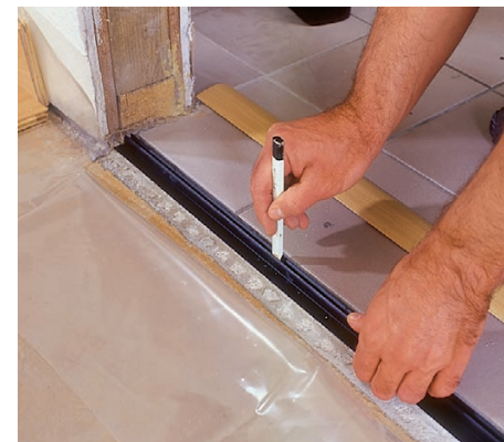
21 Dolną część składanej szyny mocujemy pod skrzydłem drzwiowym kołkami osadzonymi w jastrychowym podłożu.
