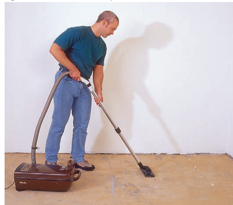
6 Następnie dokładnie odkurzamy całą powierzchnię i szpachelujemy wszystkie ubytki, których głębokość przekracza 2 mm.
