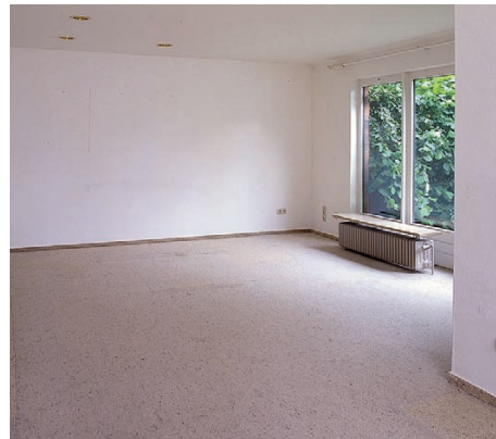
1 Stara wykładzina ma być zastąpiona parkietem bukowym. Jego panele trzeba ułożyć zgodnie z kierunkiem padania światła.
