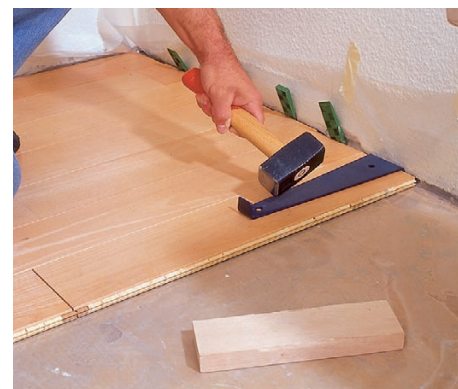
15 Gdy rzędy dołączamy odcinkami, zatrzask czołowy ostatniego panelu w rzędzie zamykamy, używając klamry i młotka.
