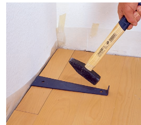
19 Ostatni rząd paneli należy przyciąć na odpowiednią szerokość i zamontować, dobijając za pomocą kłamy i młotka.
