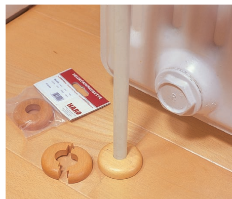
29 Do zakrywania otworów przy rurach grzewczych używa się, składanych na zatrzaski lub klej, rozetek w kolorze drewna.
