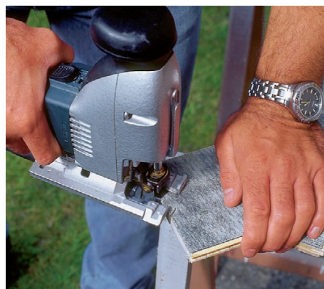
17 Wycięcia na rury nie muszą być idealnie okrągłe, ponieważ potem zostaną zakryte rozetkami z drewna lub plastiku.
