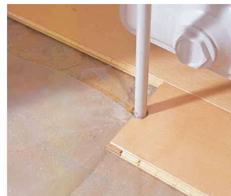
16 Przy rurach grzewczych otwory (z luzem 3 mm z każdej strony) wycinamy symetrycznie na stykach sąsiednich paneli.
