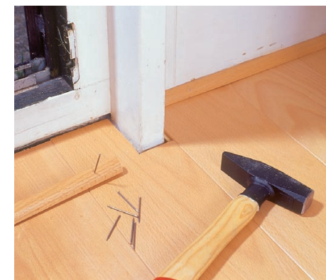
27 Przy drzwiach tarasowych zamiast listew przypodłogowych osadzamy tzw. ćwierćwałki z tego samego drewna.
