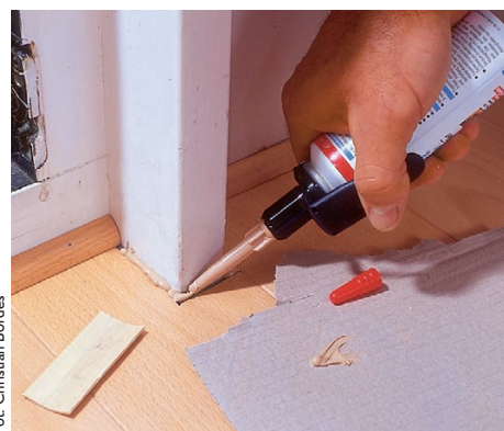
28 Szczeliny między parkietem a stalowymi ościeżnicami drzwi należy wypełnić elastyczną masą akrylową w kolorze drewna.
