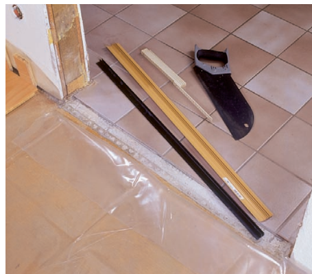
20 W drzwiach można zastosować szynę progową. Ościeżnice, po ich zdemontowaniu, podcinamy równo z powierzchnią parkietu.
