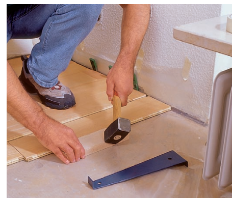
14 Czołowe krawędzie zewnętrzne skrajnych paneli w rzędach powinny tworzyć jedną linię prostą, równoległą do ściany.
