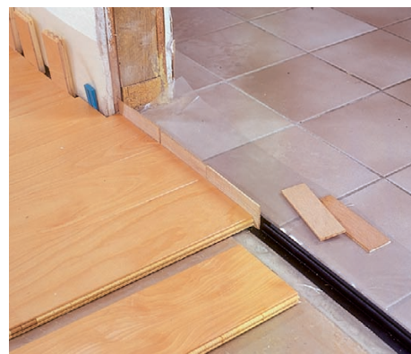
23 Panele przy progu układamy jak przy ścianach. Ich 10-milimetrowy odstęp od dolnej części szyny ustalają ścinki drewna.
