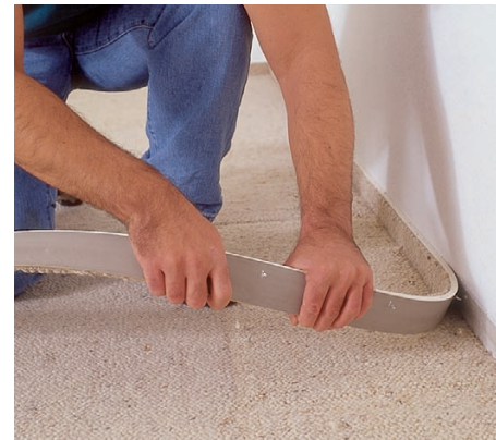
2 Plastikowe listwy przypodłogowe można łatwo zdjąć ręcznie, gdyż najczęściej są tylko przyklejone do krawędzi wykładziny.
