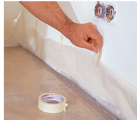
8 Na gładkim podłożu układamy folię PE. Jej pasy łączymy na 10-centymetrowe zakładki i na 20 cm wykładamy na ściany.
