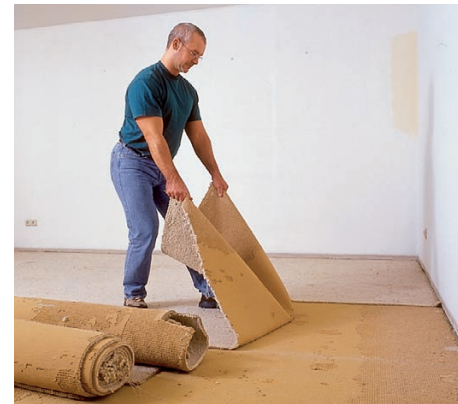
4 Krawędź pasa oddzielamy od podłoża szpachelką, tak by dało się ją silnie chwycić oburącz i odrywać, ciągnąc ku górze.
