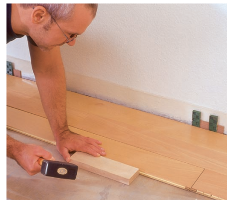
11 Przez drewniany klocek ostrożnie dobijamy młotkiem kolejne rzędy, tak by szczelina zamknęła się na całej długości.
