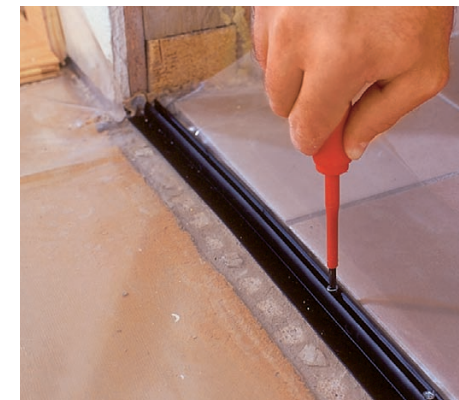
22 Brzeg folii jest dociskany szyną do podłoża. W pasowaniu długości szyny uwzględniamy grubość zdjętych ościeżnic.
