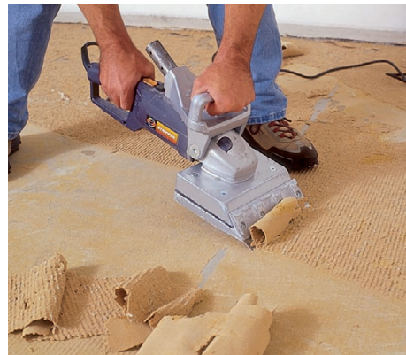
5 Resztki kleju i wykładziny usuwamy szpachelką lub wypożyczonym narzędziem elektrycznym, zwanym z angielska stripperem.
