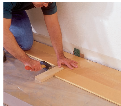
12 Można też odcinki kolejnego rzędu dołączać pojedynczo, a potem wzdłużnie dobić je do siebie młotkiem i klokiem.
