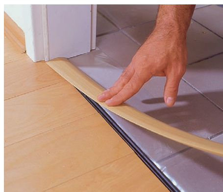
30 Na zakończenie w drzwiach nakładamy na zamontowaną dolną szynę ozdobną pokrywę, niwelującą różnicę poziomów.
