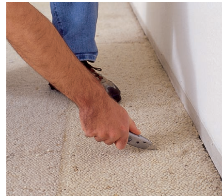
3 Wykładzinę przyklejoną całą powierzchnią do podłoża tnijemy nożem na pasy szerokości jednego metra, by łatwiej ją było usunąć.
